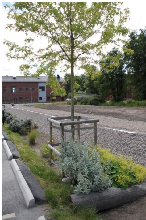
Figur 16. Foto av nyanlagt biofilter i Kviberg, Göteborg. Biofiltret ligger i anslutning till en ca 650m 2 stor parkeringsplats. Foto: Anna Dahlström, Sweco.
