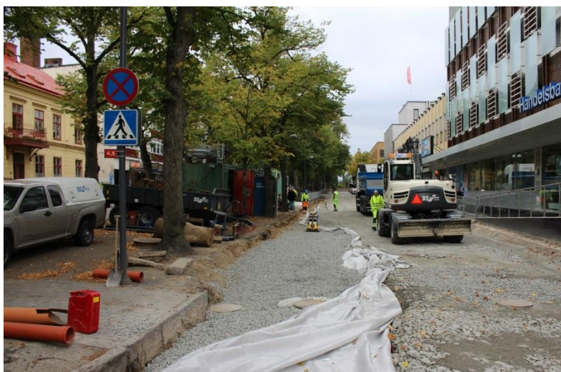
Figur 9. Anläggning av Västra Esplanaden i Växjö. Halva körbanan (den till vänster) utgörs av en dränerande konstruktion. Högra halvan närmast husen är en standardkonstruktion. OBS! Detta är en bussgata med frekvent tung trafik! Till vänster i bild syns trädallén.
