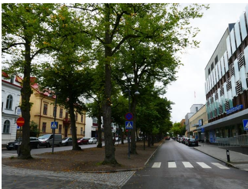
Figur 10. Västra Esplanaden i Växjö 2 år efter anläggandet. Inga synbara deformationer.
