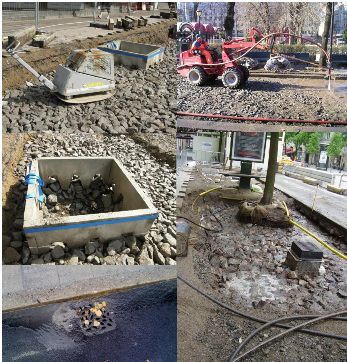
Figur 21. Anläggnings av skelettjordskonstruktion. Nederst till vänster syns brunnslock för vattenintag. Notera öppningarna i form av små blad.
