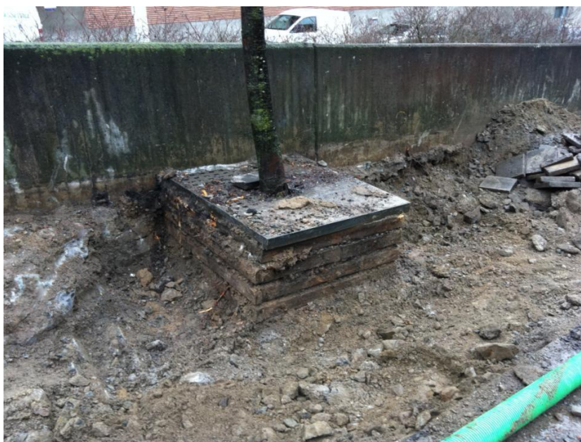
Figur 20. Typisk bild av trädplanterinar i staden. En liten volym jord och sedan tätt bär- och förstärkningslager.
