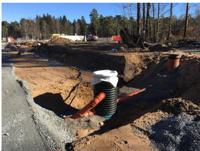
Figur 17. Anläggningsarbete i Uppsala. Foto: Kent Fridell Edge/SLU
