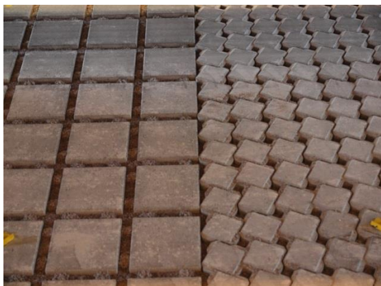
Figur 7. Dränerande yta med betongmarksten. 20 % fogyta till vänster och 10% till höger.
