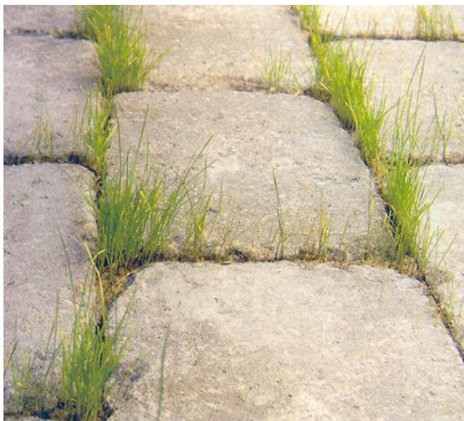
Vanlig fogsand som har blivit hårt angripen av ettårig kärngröe, en av de vanligaste typerna av ogräs i betongbeläggningar. Ettårig kärngröe sprider frö hela året.
