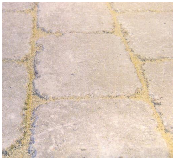
Samma beläggning men med Starka Ogräshämmande Fogsand. Ingen spridning av ettårig kärngröe eller andra typer av ogräs.
