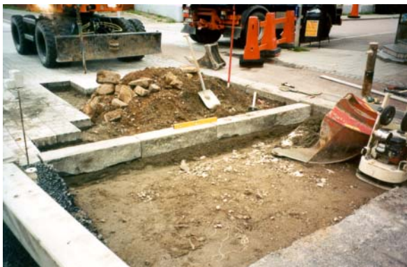
Kantsten satt i betong förstärker kanten hos markstensbeläggningen.
