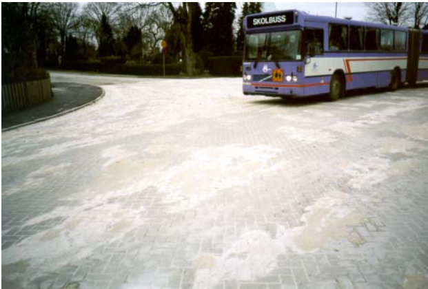
Eftersandning av nylagd markstensyta.
