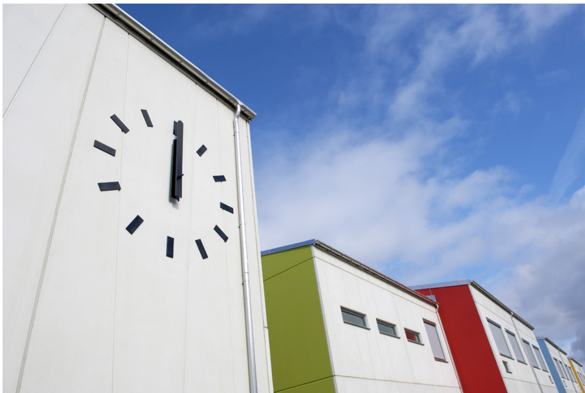
Infärgad yta i vitbetong samt klotterskydd (Fladängsskolan, Lomma)
