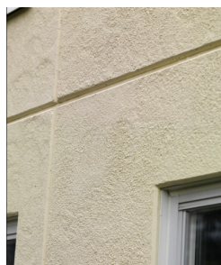
Målad yta (Kv Landsdommaren, Lund)
