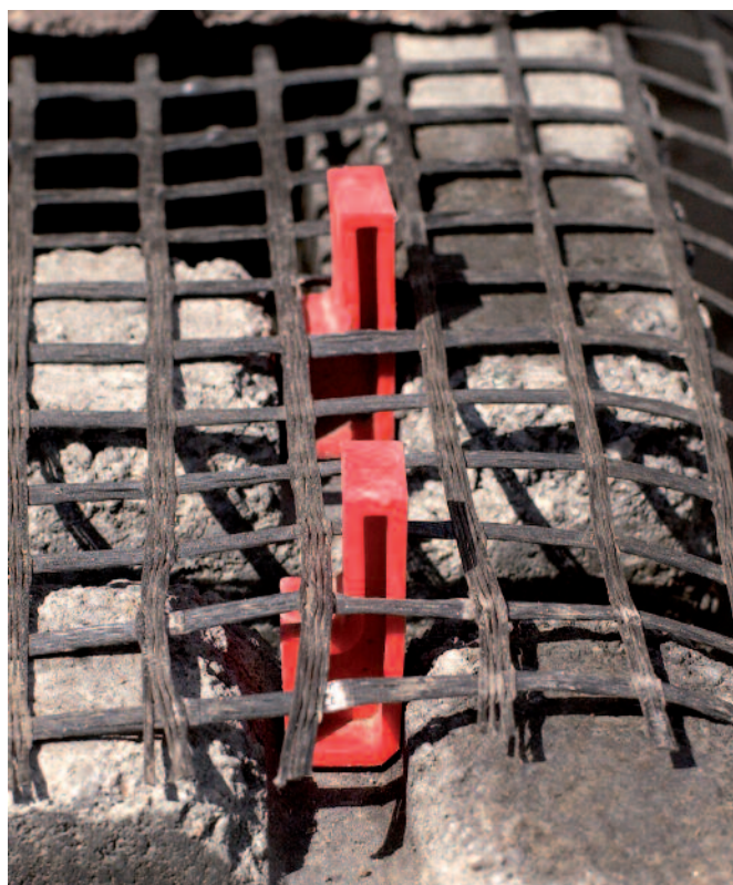
Murbyggnation med Geoloc® och Geonät (jordarmering)
